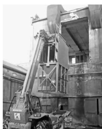
INSTALACE nové technologie do haly slévárny. Foto: Motor Jikov
