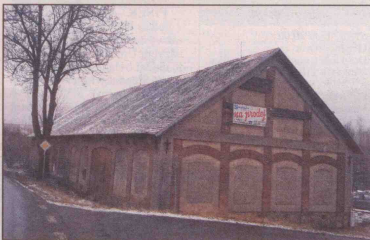
Původní stav chátrající stodoly.
